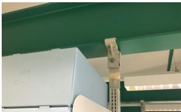
Wegen der geringen Tragkraft des Dachgeschosses sind die Magazinregale an den Deckenträgern aufgehängt. Foto: VdA
