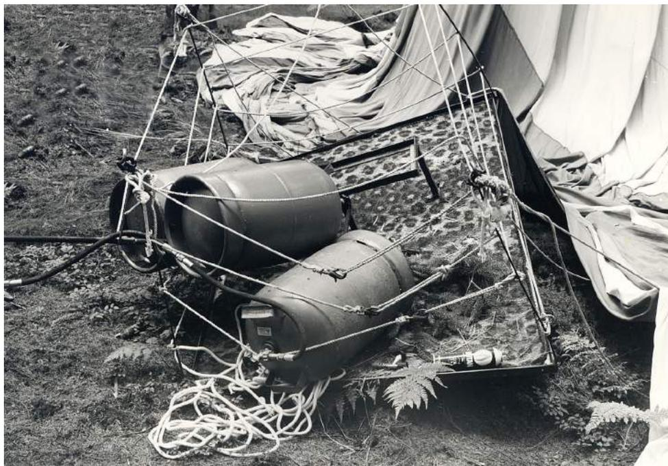
*Die Gondel des ersten Ballons. Darin liegen die Propangasflaschen, mit denen der Brenner des Ballons betrieben worden war.*
